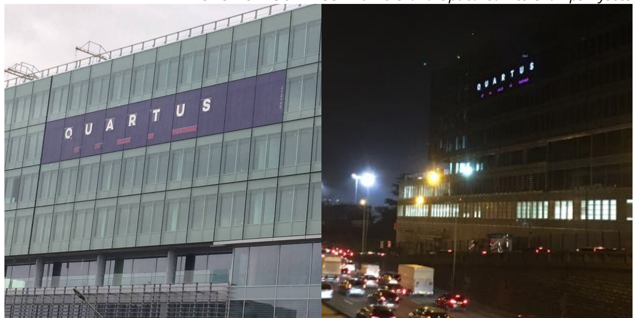
Une visibilité de loin - Habillage immeuble Quartus au bord du périphérique parisien
